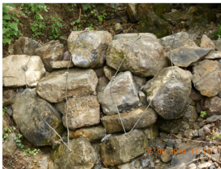
Soglia in massi ancorati a monte dell'attraversamento stradale della valle Masna (giugno 2014)
