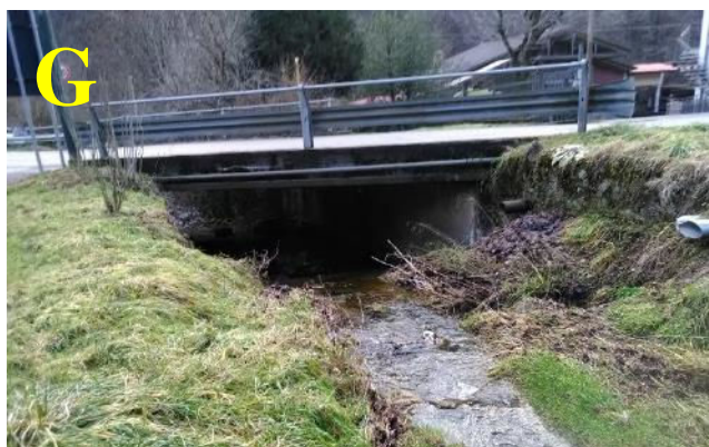
ponte in via 5 Martiri: ingresso, con soglia (G); uscita a valle della strada con lato strada esondabile (H)
