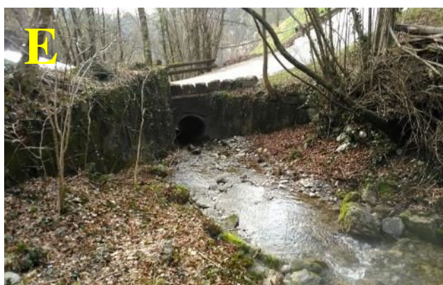
tombotto sulla valle Masna lungo via Netura (E) e la strada per Netura su cui può esondare il torrente (F)
