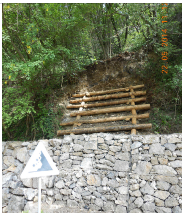
Gabbioni e grate camera (intervento 3 e 4) presso valle Cugnai
