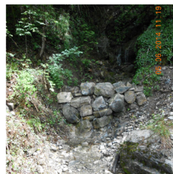
Soglia in massi ancorati a monte dell'attraversamento stradale della valle Masna (giugno 2014)
