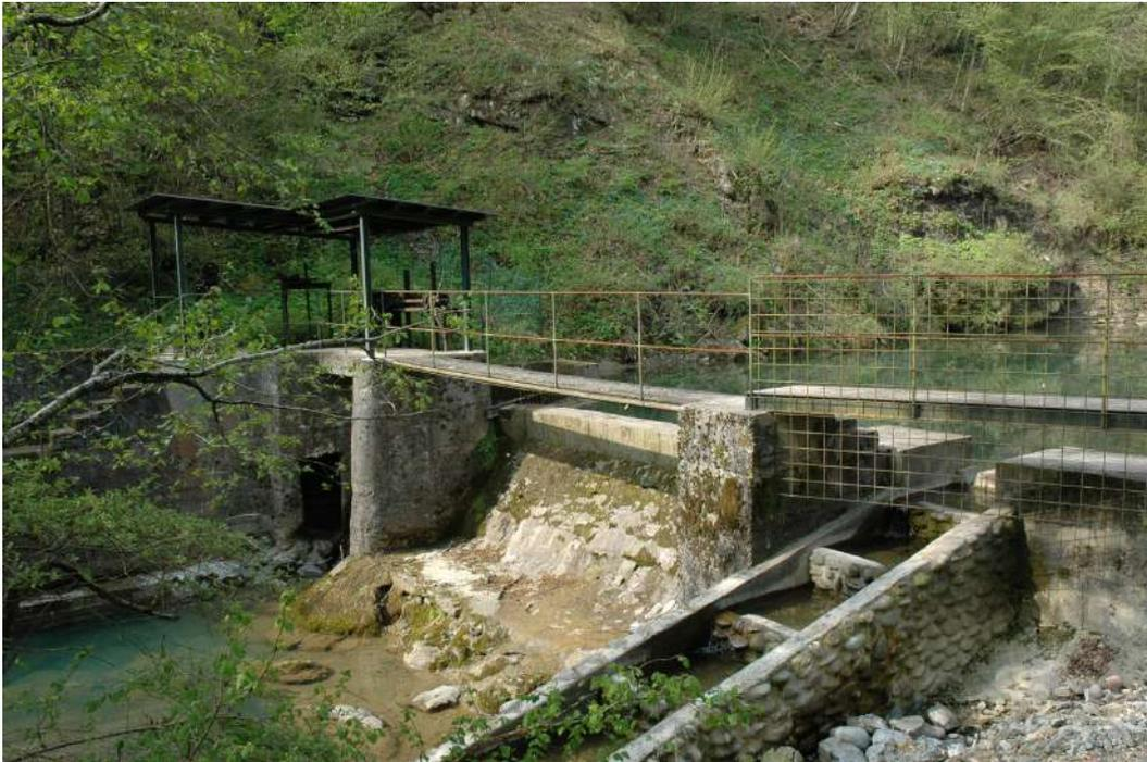
Traversa per la derivazione d'acqua per usi industriali.
