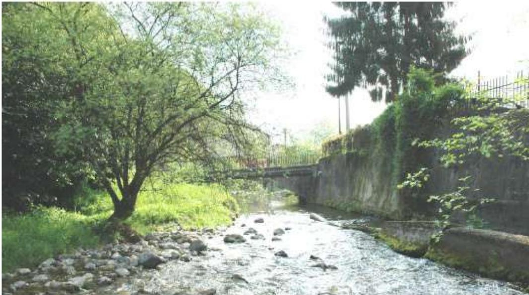
Un altro esempio di strozzatura del Vertova con la sezione di un ponte sotto dimensionato e sovralluvionato
