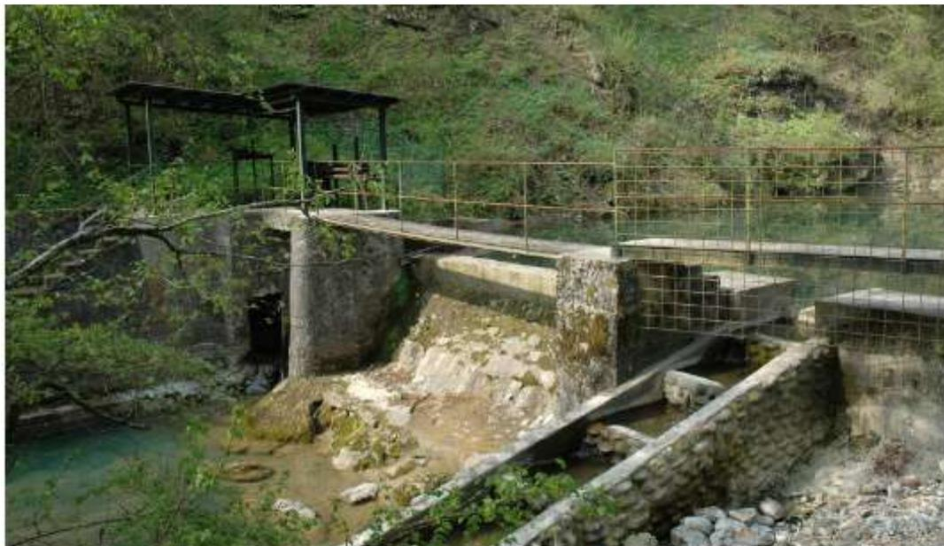
Traversa per la derivazione d'acqua per usi industriali.
