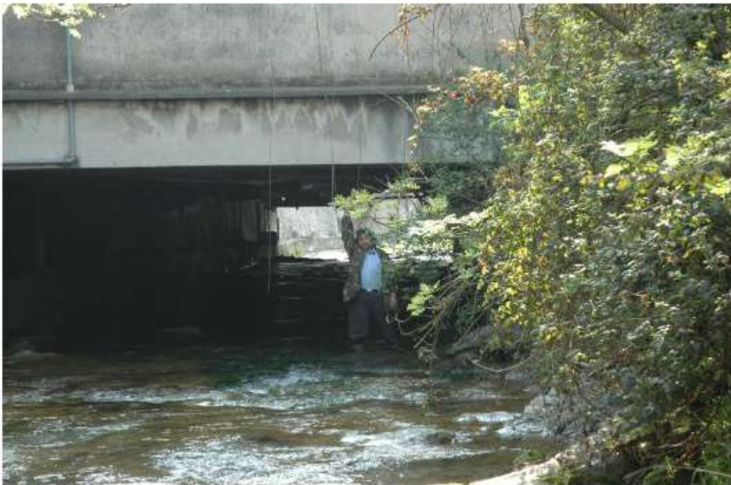
Particolare della sezione di cui sopra, questa sezione per smaltire circa 200 mc/sec dovrebbe essere almeno 3,50 metri di altezza
