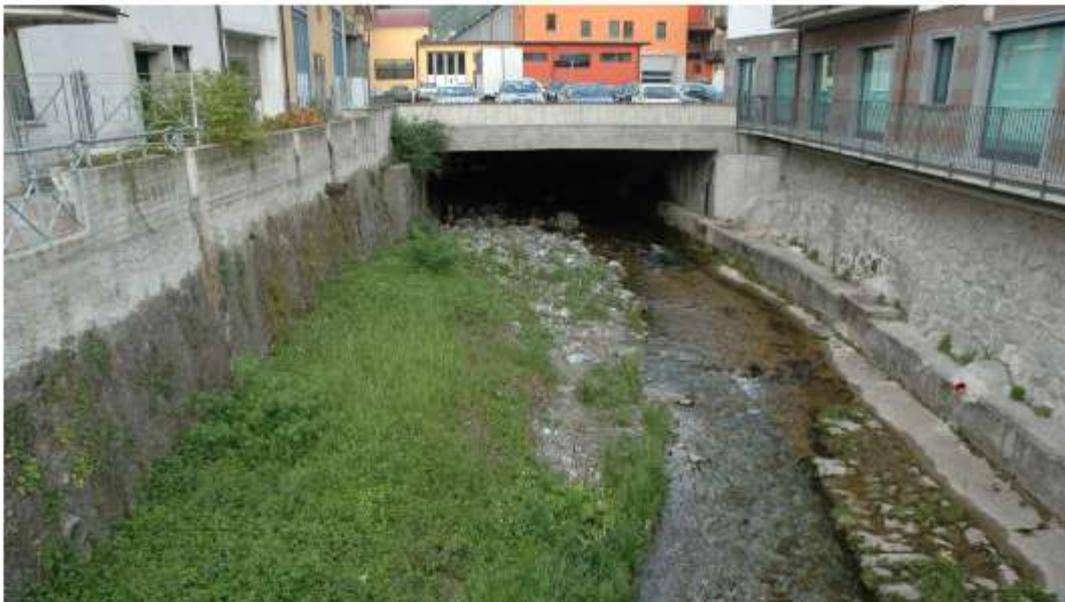
Vista dalla Piazza verso monte , in cui si può osservare , oltre alla sezione ristretta e insufficiente già citata nelle prime foto, anche il deposito alluvionale che riduce sensibilmente la sezione dell'alveo.
