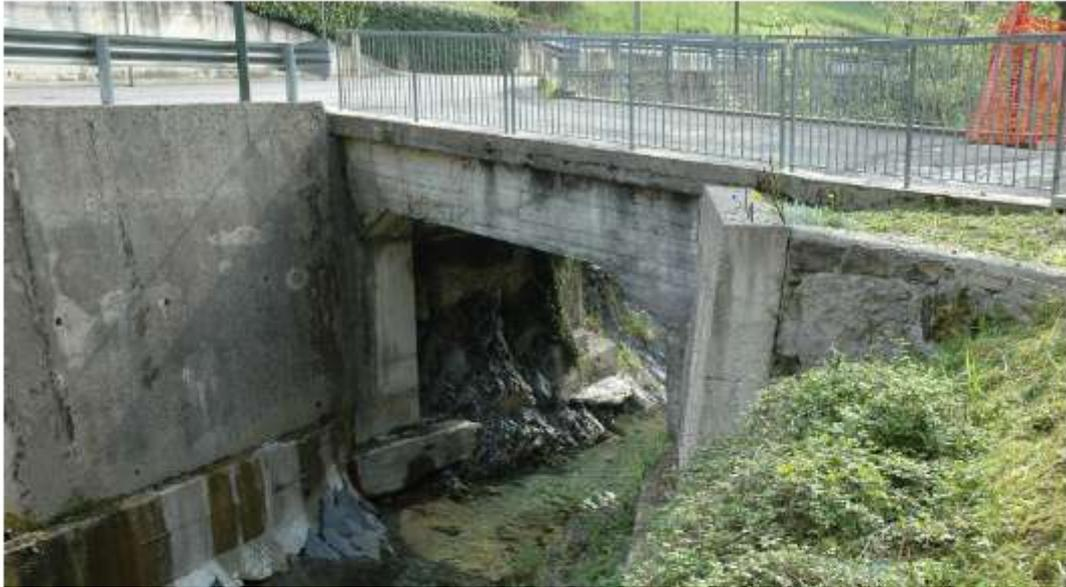
Altro punto sul Vertova dove la sezione dell'alveo è decisamente insufficiente sia per lo smaltimento della portata liquida che della portata solida
