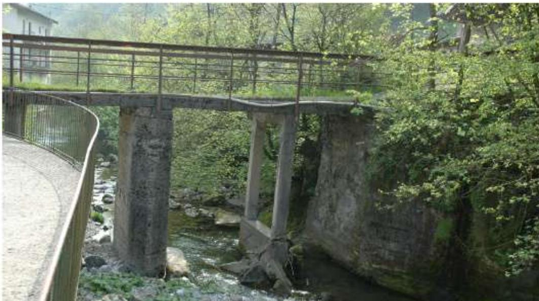
Altro punto sul T. Vertova in cui la sezione è decisamente disturbata sia per il passaggio delle portate liquide calcolate, sia per il trattenimento di una certa quantità di materiale preso in carico dal corso d'acqua
