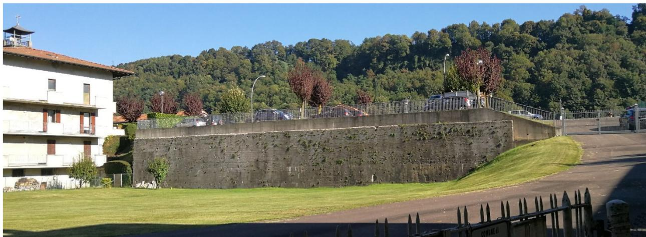
*Riporto di via Don Ferrari e della ferrovia visto da via Pizzo (sopra) e da via don Ferrari durante i lavori di sistemazione della pista ciclopedonale (sotto): a) scavo, b) terre armate.*
