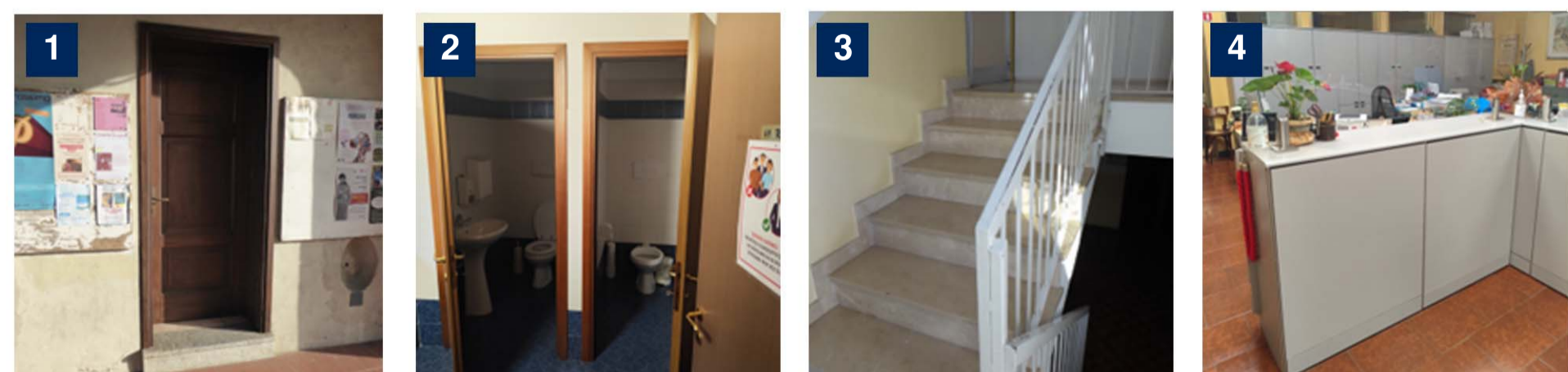
1 Dislivelli all'ingresso principale | 2 Servizi igienici non accessibili | 3 Assenza di sistemi di collegamento verticale accessibili | 4 Arredi con altezza e configurazione non accessibili
